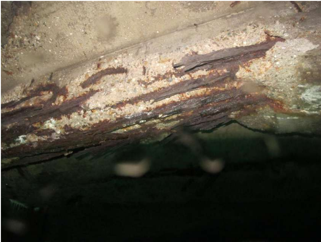
а) Стан залізобетонних рігелів
