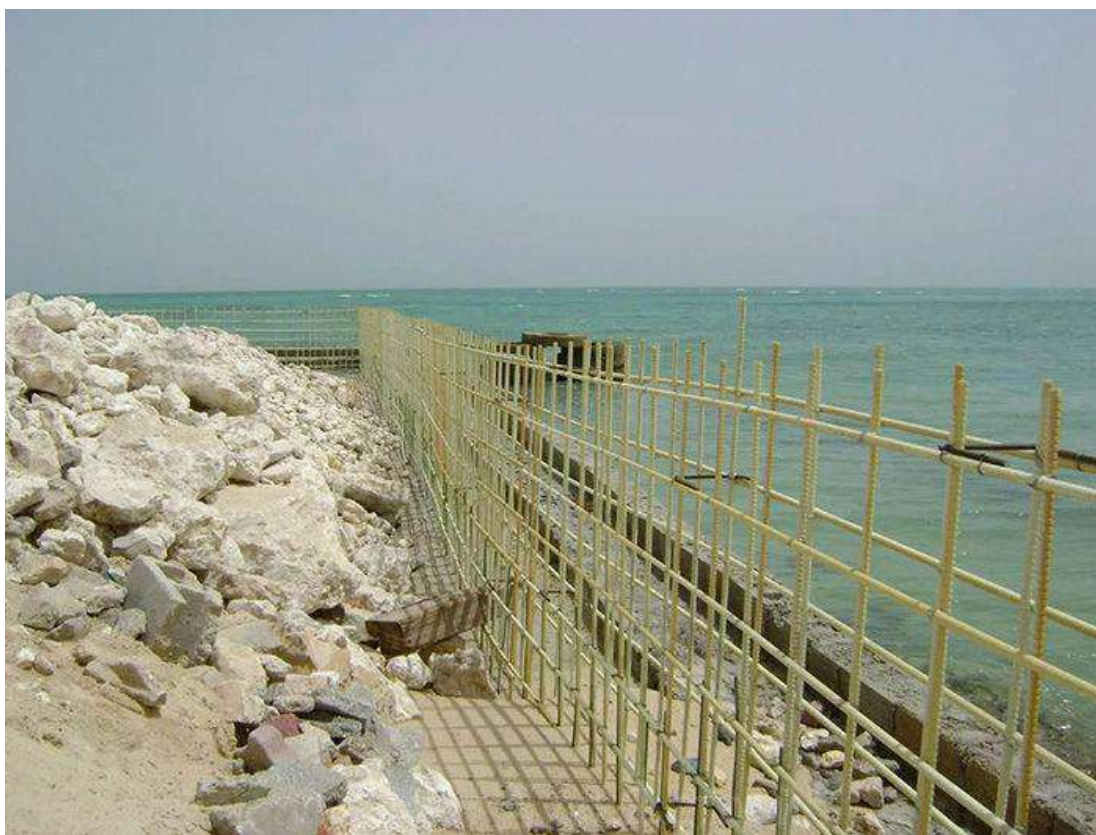
Рис.1.3 Використання композитної базальтопластикової арматури
