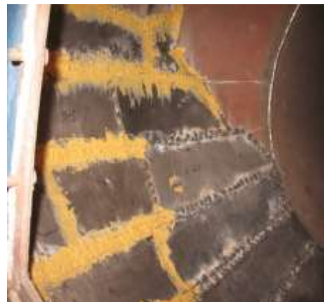
Рис.10. Монтаж вставок у вхідному патрубку вентилятора
