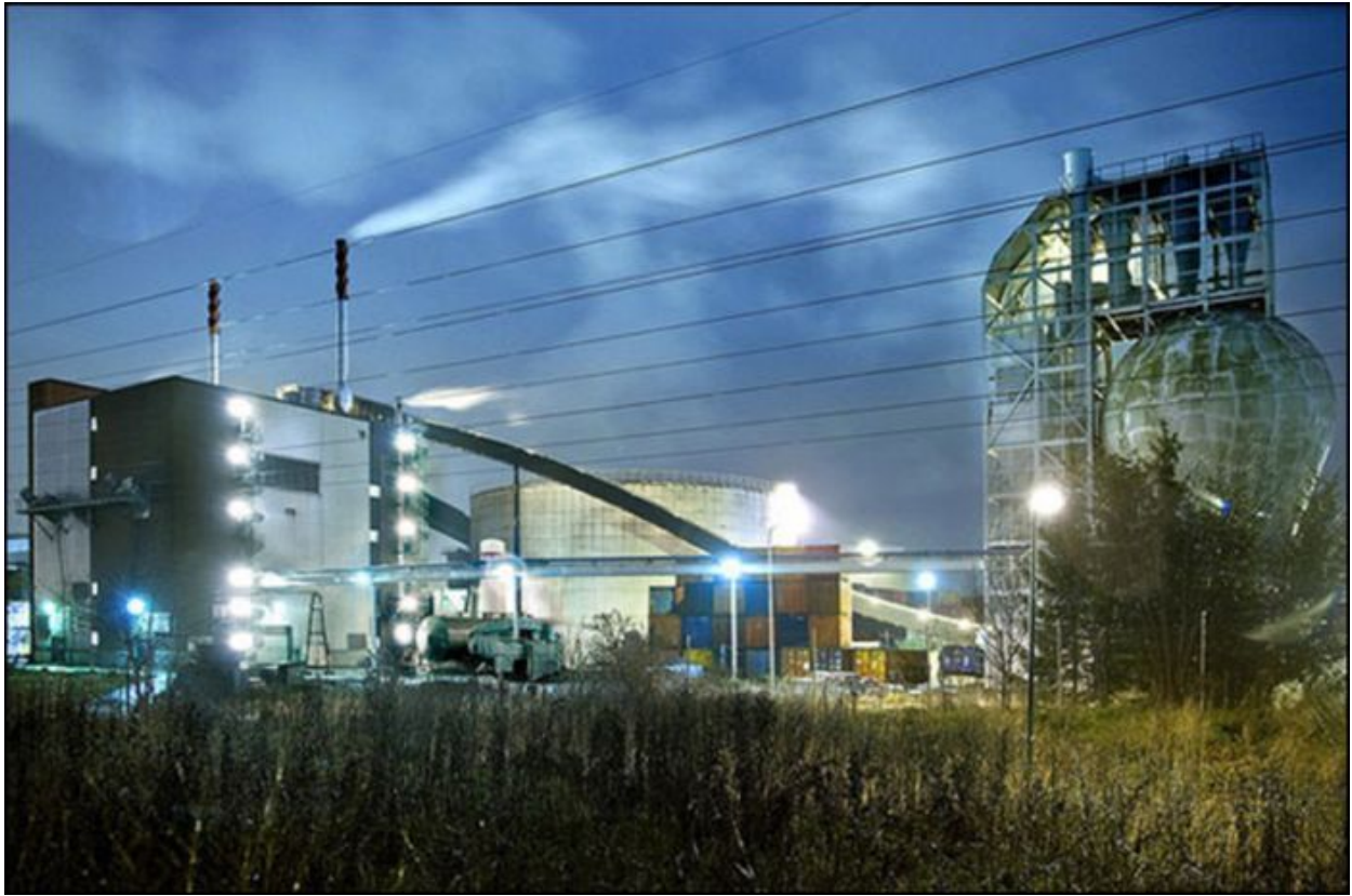
Рис 8. СПЗ в м. Неаполь. Італія. Загальний вигляд.
