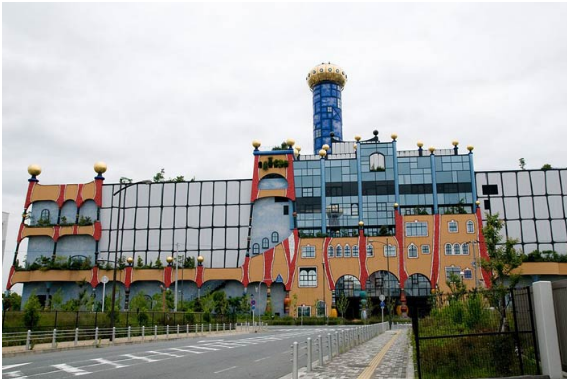
Рис 7. СПЗ в Вене, Австрія. Загальний вигляд.
