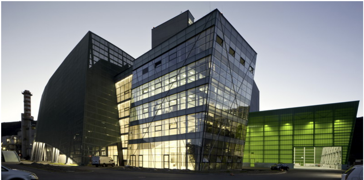
Рис 9. СПЗ в м. Больцано. Італія. Загальний вигляд.
