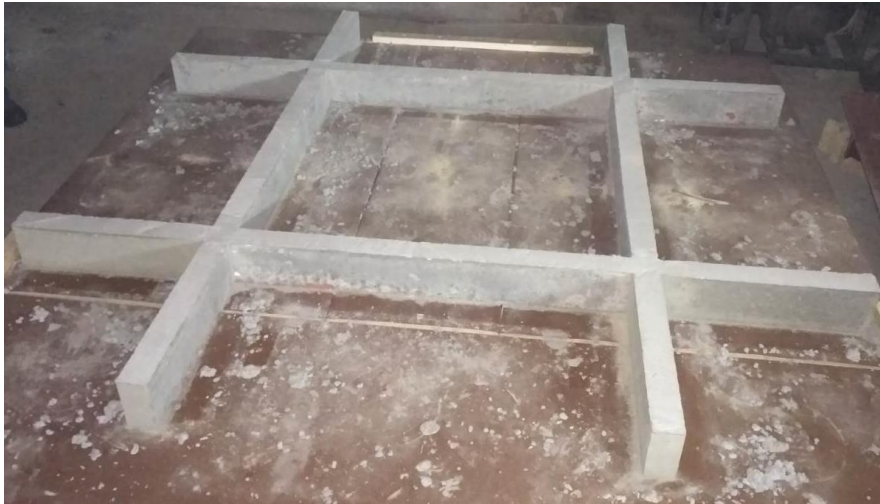
Рис. 3. Загальний вид перехресно-балкової системи, підготованої до випробувань
