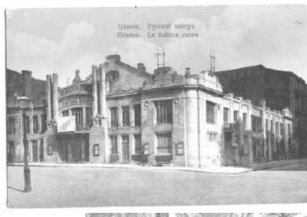
Рис.2. Здание одесского Русского театра, перестроенное из хлебных складов.
