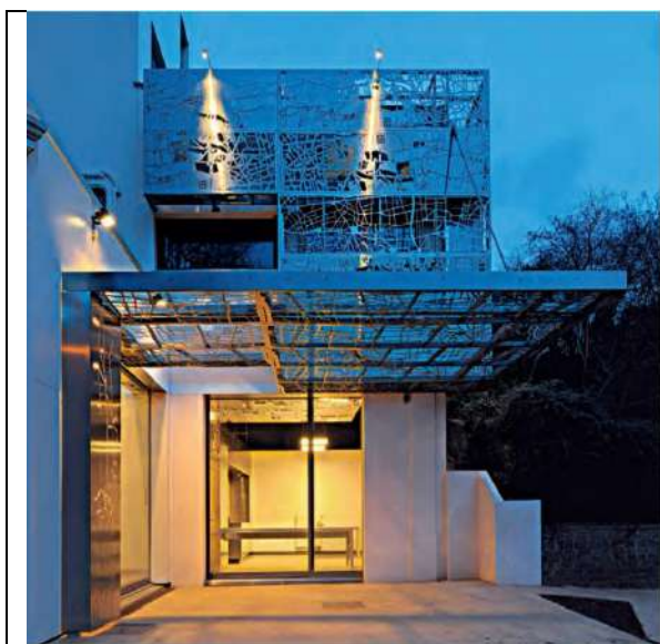
Рис. 1. Панели с рисунком выполненным при помощи лазерной резки. Брюссель
