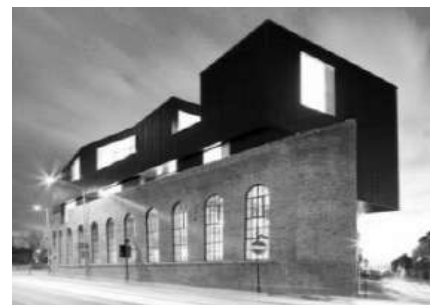
Рис.4. Надстройка над старым кирпичным складом в Шеффилде
