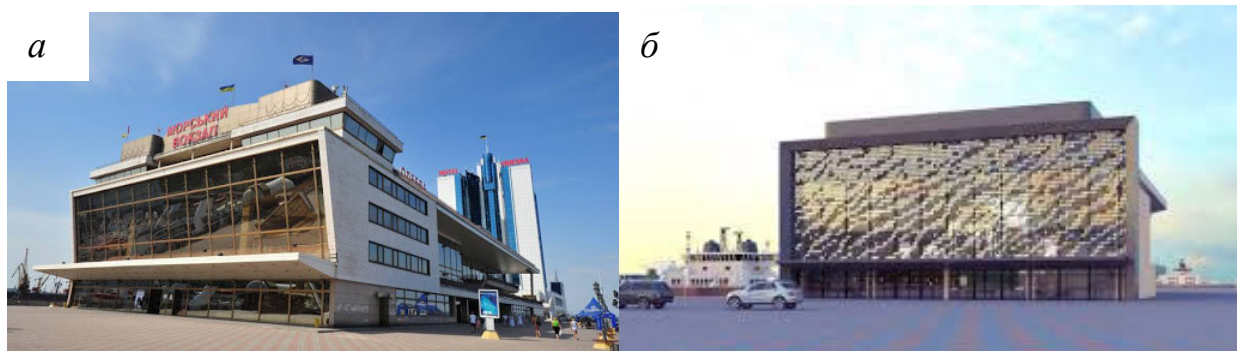
Рис. 14. Зальний вигляд будівлі морвокзалу: а – до реконструкції; б – після реконструкції
