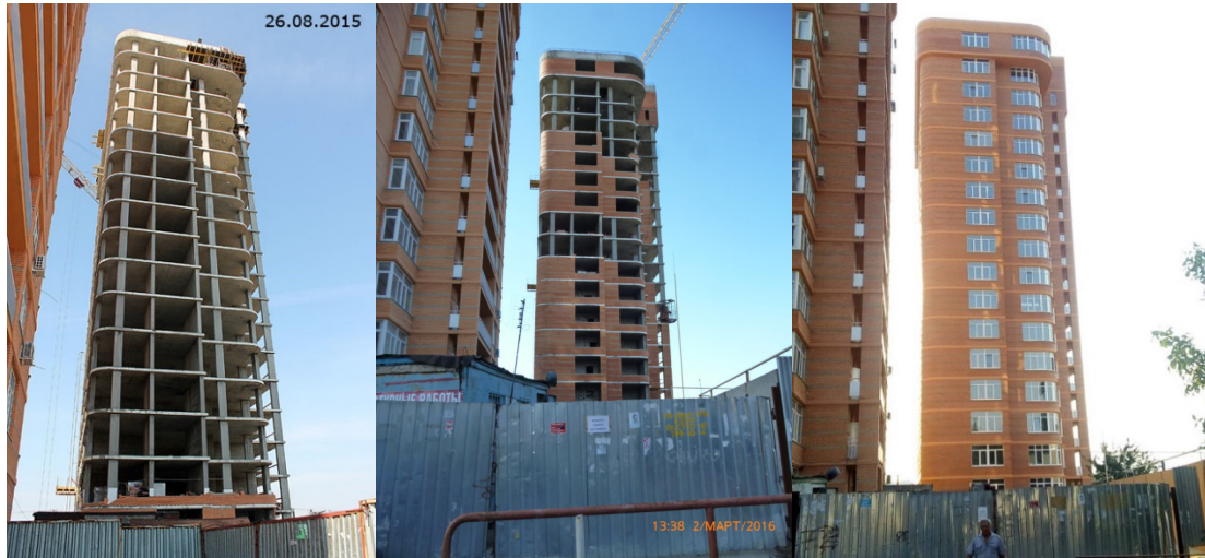
Рис. 7. Три етапи зведення будівлі, на яких проводили випробування
