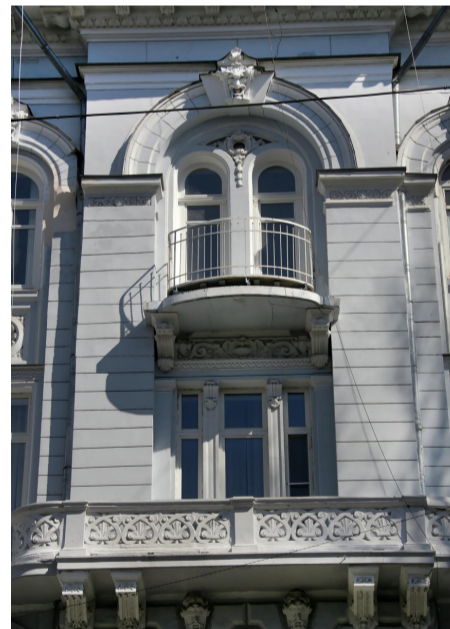
Фрагмент фасаду будинку Маврокордато
