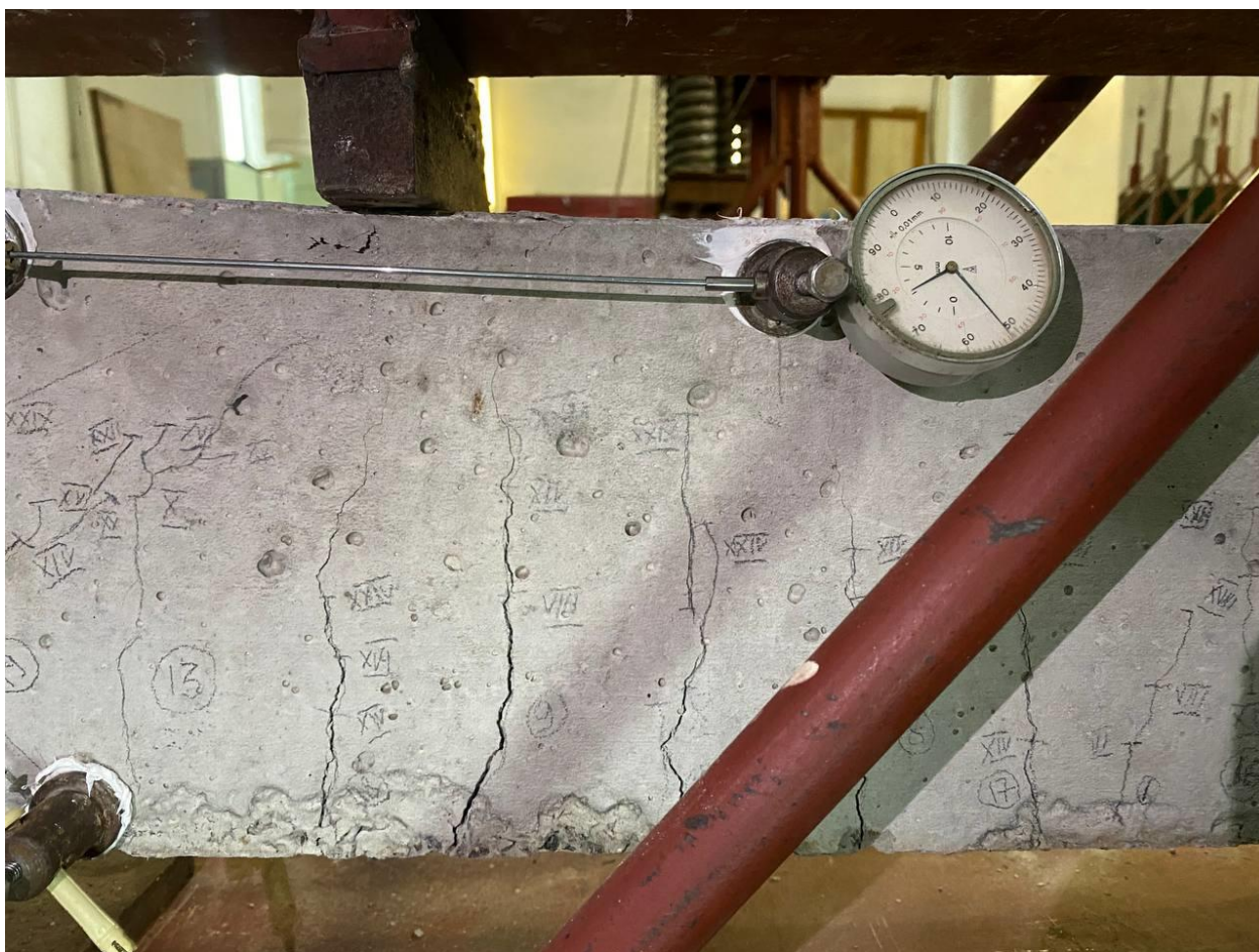
Рис. 5.8. Тріщини у непошкодженій балці
