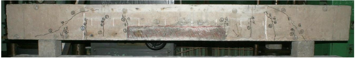
Рис. 3.43. Тріщини у зразку ЗБП5
