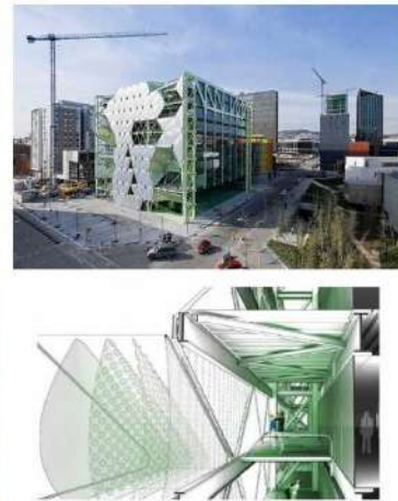
Media-TIC (Іспанія, Барселона) Загальний вигляд, деталь фасадної системи
