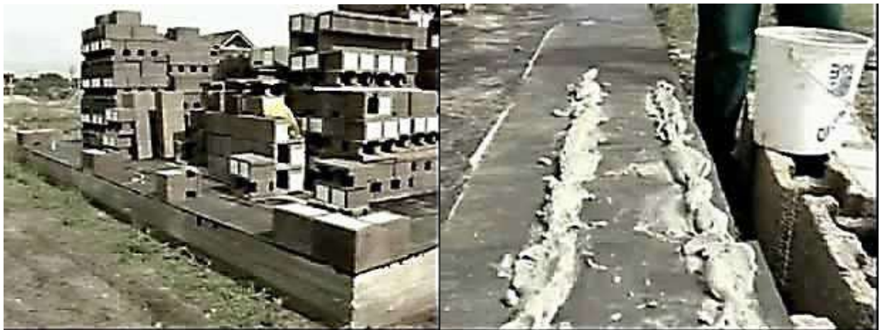
Рис. 1.7 – Установка блоків на арматурні стрижні: а) - розмітка кутових блоків на фундамент; б) - установка першого ряду на розчин
