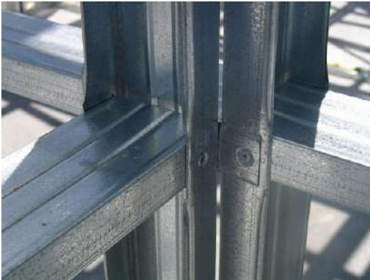
Рис. 5.8 – Приклад з'єднання профілів
