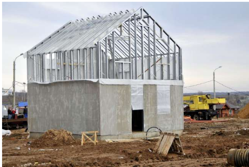
Рис. 5.13 – Кріплення незнімної опалубки (з ЦСП) на каркас з ЛСТК
