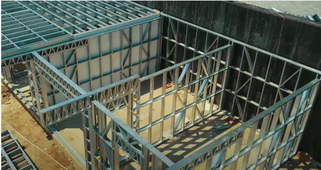
Рис. 5.11 – Змонтований каркас стін з ЛСТК
