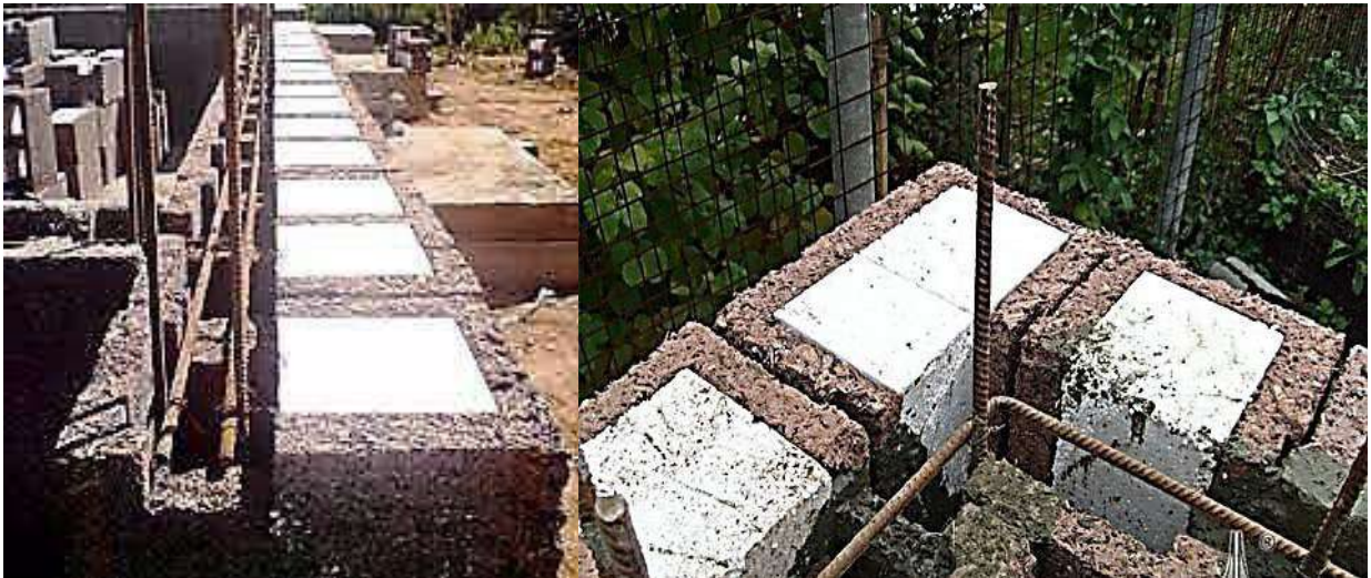
Рис. 1.8 – Установка наступних рядів блоків і армування: а) - горизонтальної арматури; б) - вертикальної арматури
