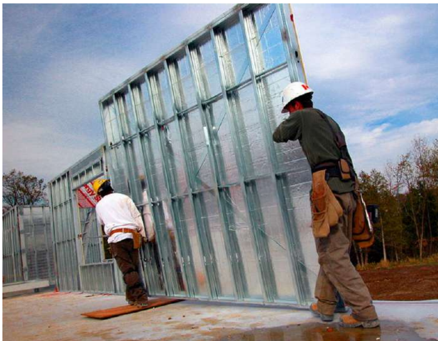
Рис. 5.12 – Встановлення каркасу стін з ЛСТК монтажниками
