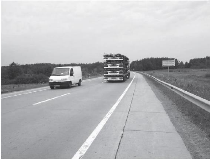
Рис. 1.1 Автомобільна дорога Київ-Ковель з ділянкою із цементобетонного покриття після 12 років експлуатації [30]
