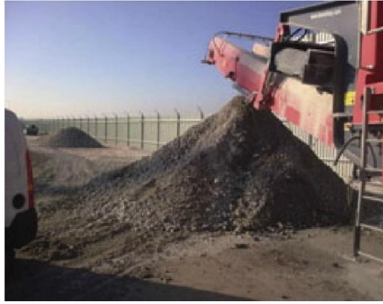
Рис. 1.2 Подрібнення демонтованого бетону в міжнародному аеропорті Лісабону [86]
