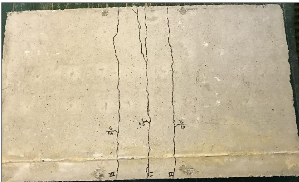
Рис. 2.32. Розташування поперечних тріщин на нижній грані плити
