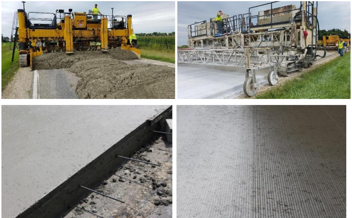
Рис. 1.5 Процес влаштування сталевіфібробетонного покриття, штат Айова
