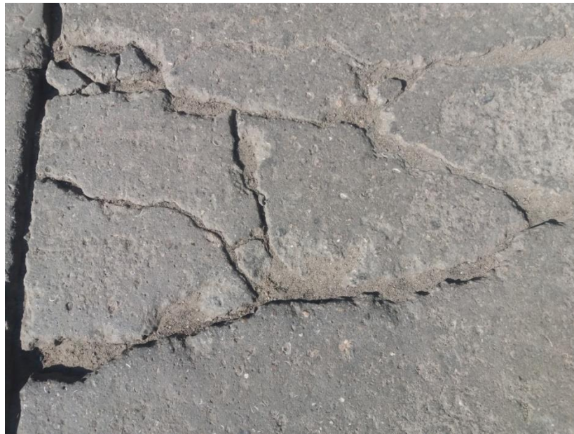
Рис. 1.16 Пролом покриття
