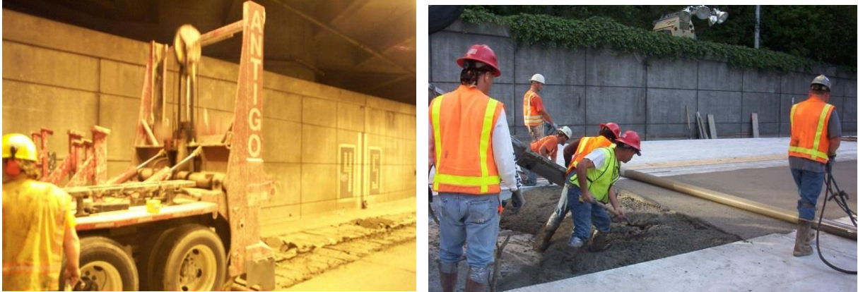
Рис. 1.4 Ремонт покриття швидкотвердіючим бетоном з додаванням сталеві фібри, штат Вашингтон, США
