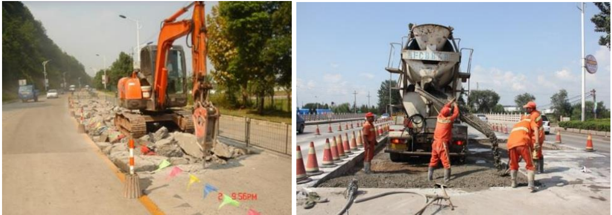
Рис. 1.2 Ремонт покриття з використанням технології full-depth repair
