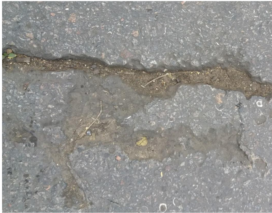
Рис. 1.14 Відкол кромки у стику з одночасним руйнуванням герметику у шві
