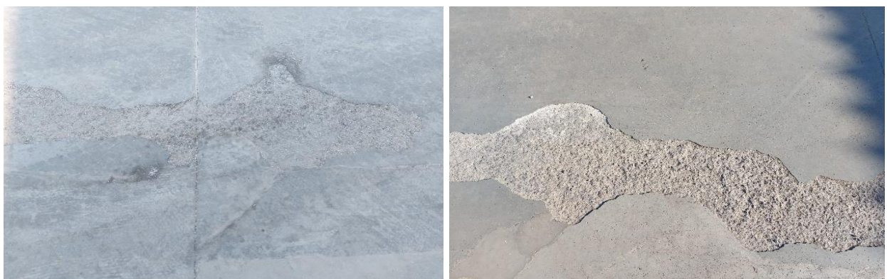
Рис. 1.7 Відшаровування верхнього шару покриття
