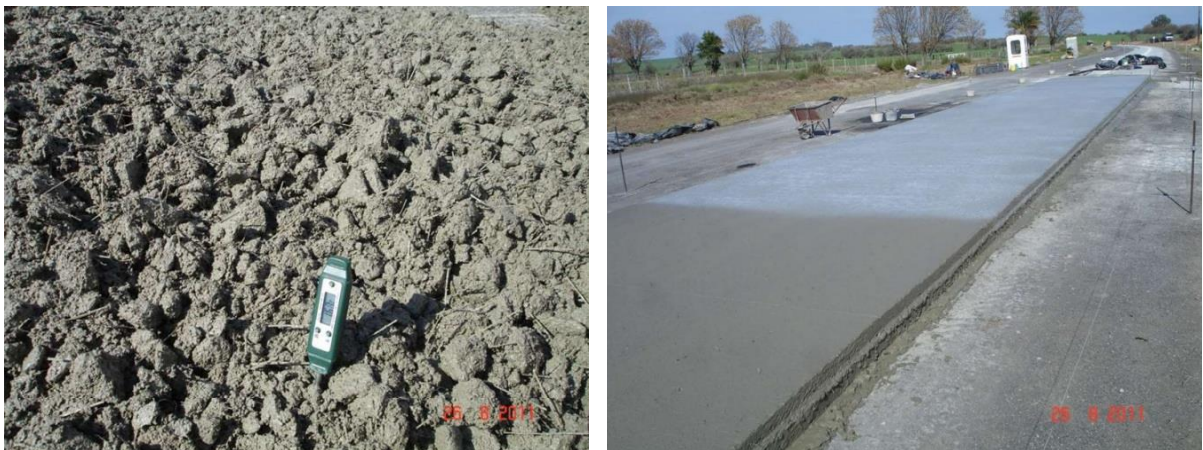
Рис. 1.6 Влаштування підсилюючого шару зі сталевіфібробетону, Уругвай
