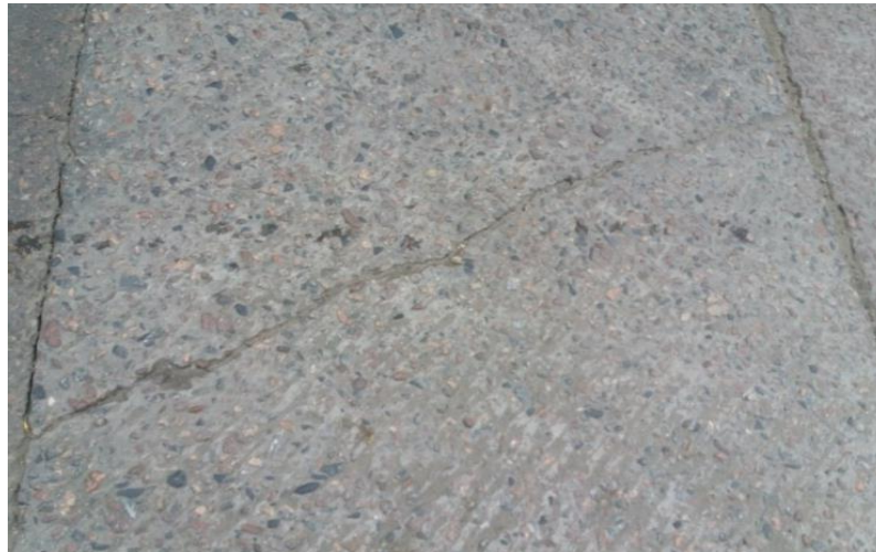
Рис. 1.10 Діагональна тріщина
