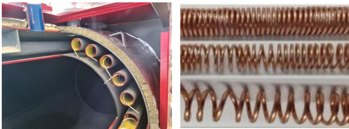
Рис. 2.2. Спіральні вставки для покращення теплообміну в котлах:
