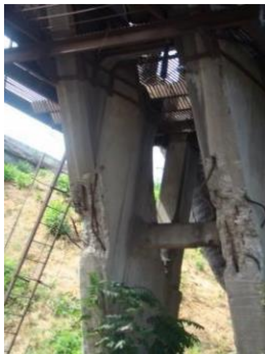
Рис. 1.1. Пошкодження залізобетонних конструкцій
