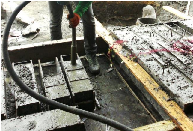
Рис. 2.11. Бетонування призм та кубів
