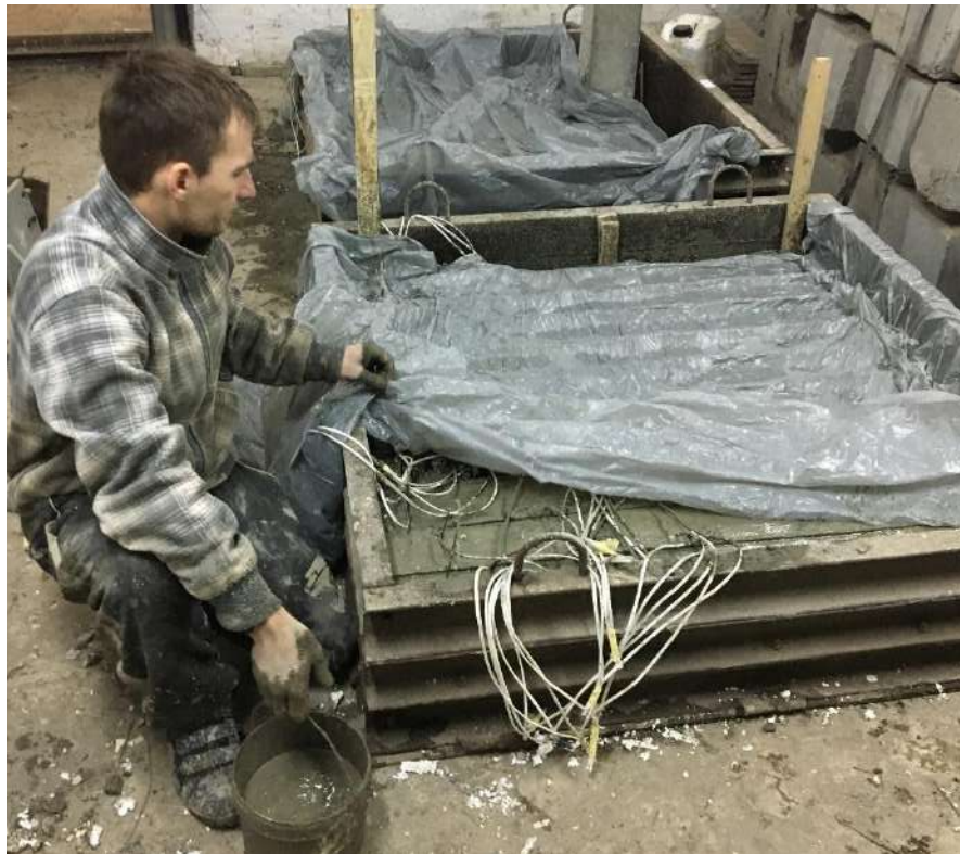
Рис.2.7. Завершальний етап бетонування дослідних зразків.
