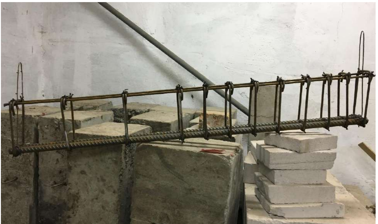
Рис.2.2. Арматурний каркас, виготовлений для дослідних зразків-балок з прогіном зрізу 510 мм)
