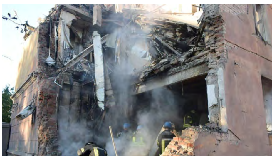
Рисунок 1.3 – Пошкоджений житловий будинок у м. Слов'янськ, Донецька область
