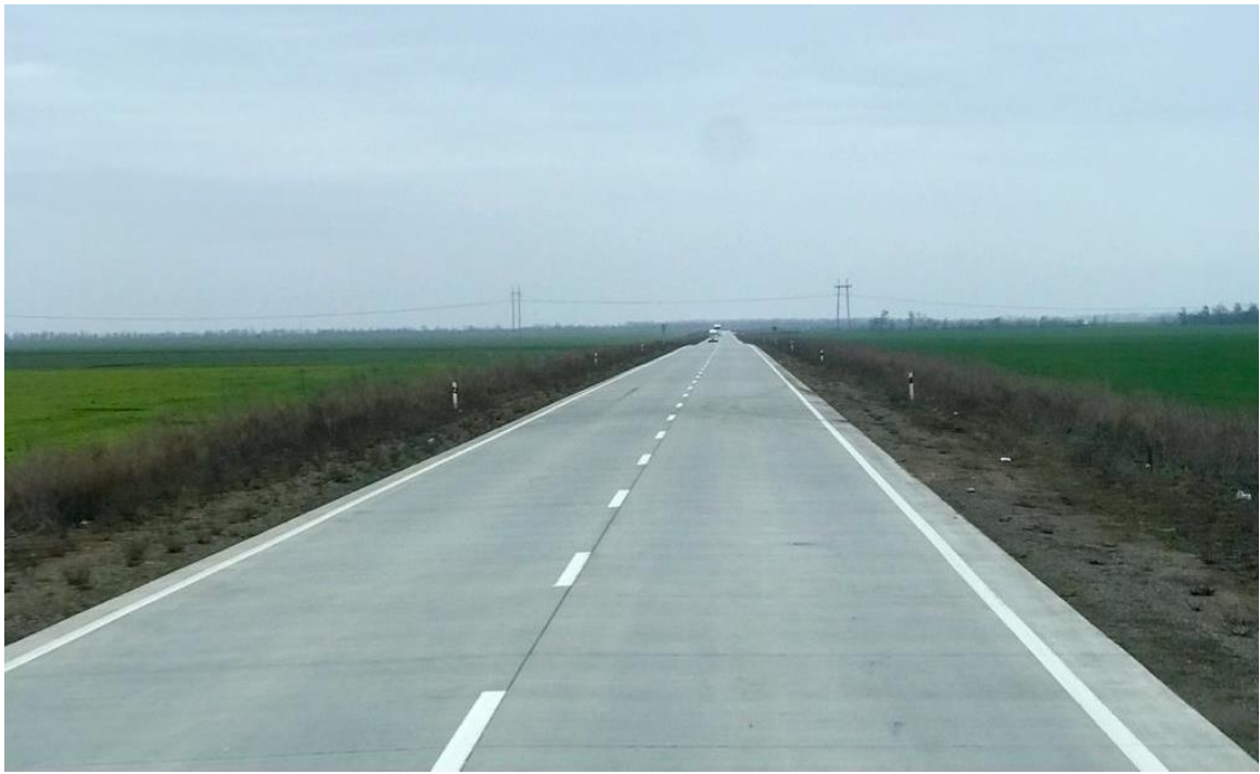
Рис.1.2 Ділянка траси Н-14 Кропивницький-Миколаїв з цементобетонним покриттям [17].
