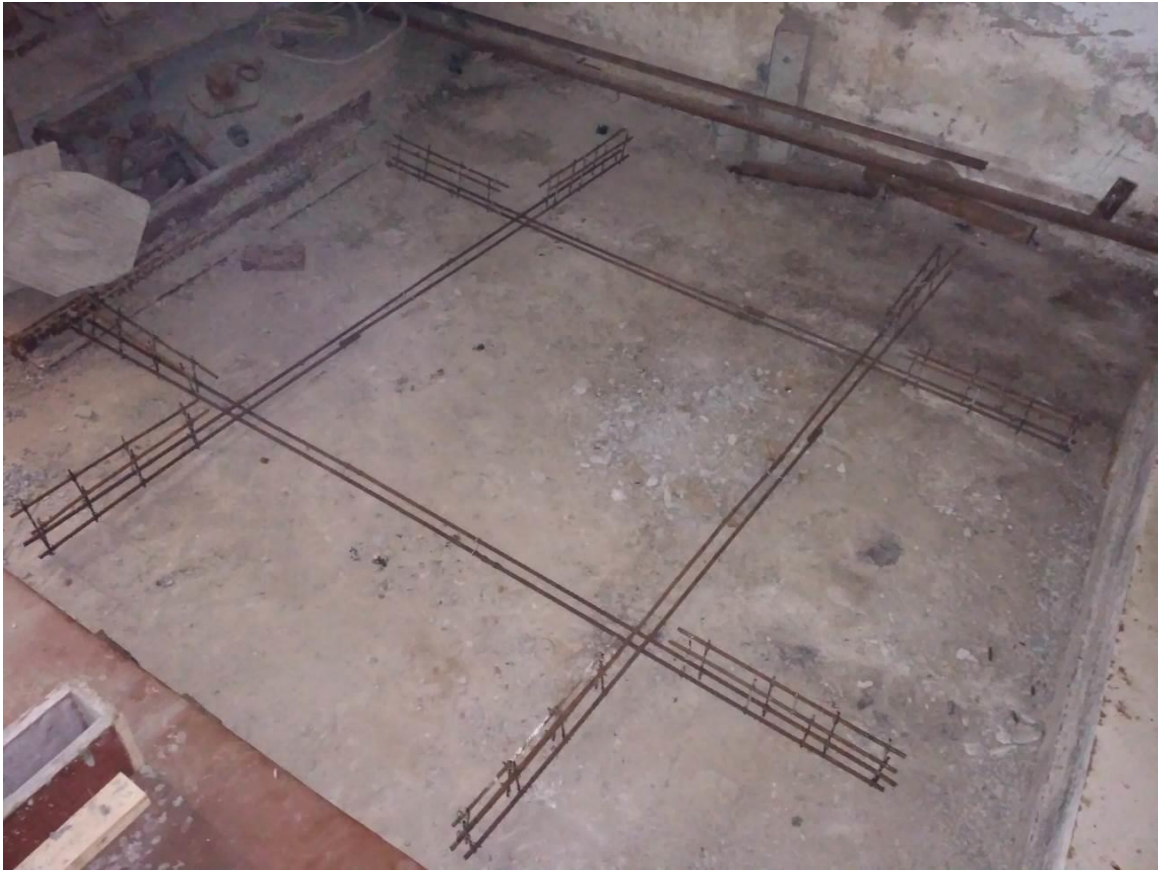
Рис. 3.5. Каркас дослідної перехресно-балкової системи
