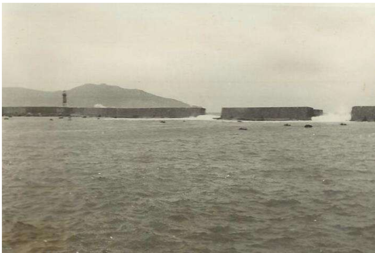
Рис. 1.10 Пошкодження молу «Мустафа» в Алжирі морськими хвилями
