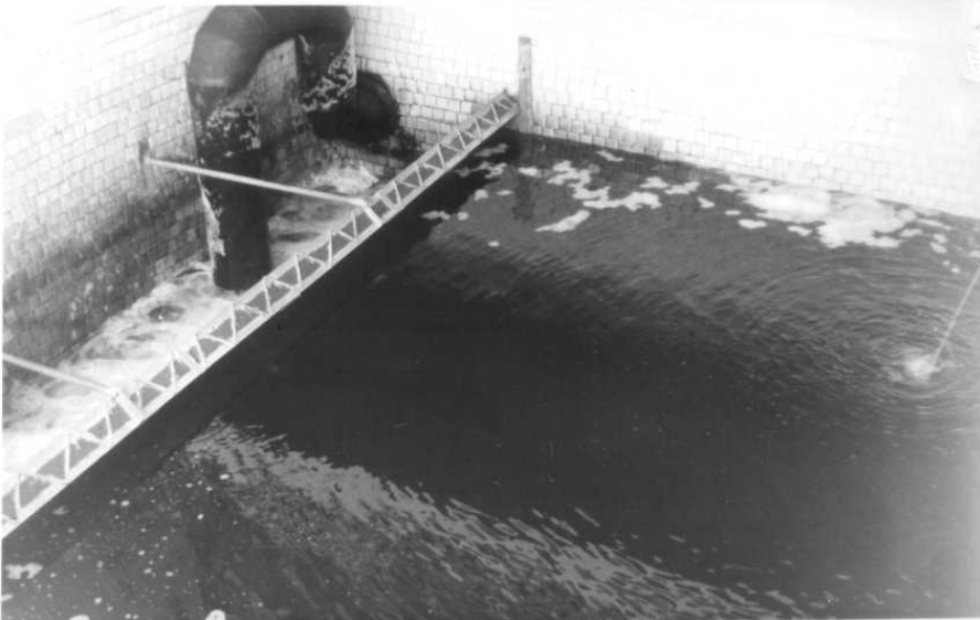
Мал. 2.10 Пористе відведення: верхній знімок – водоповітряне промивання, нижче – водяне промивання
