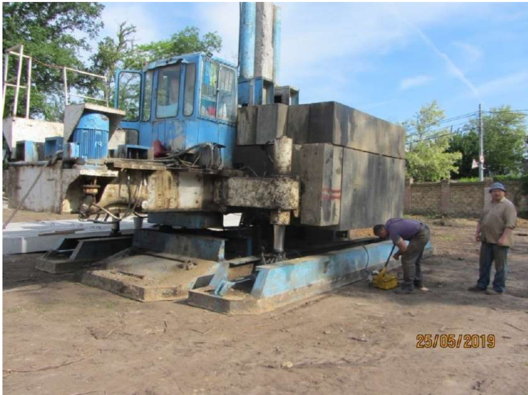
Рис. 5.17. Статичні випробування паль під цивільну будівлю з використанням пальовдавлюючої установки. Керівник робіт – с.н.с. Кушак С.Й.
