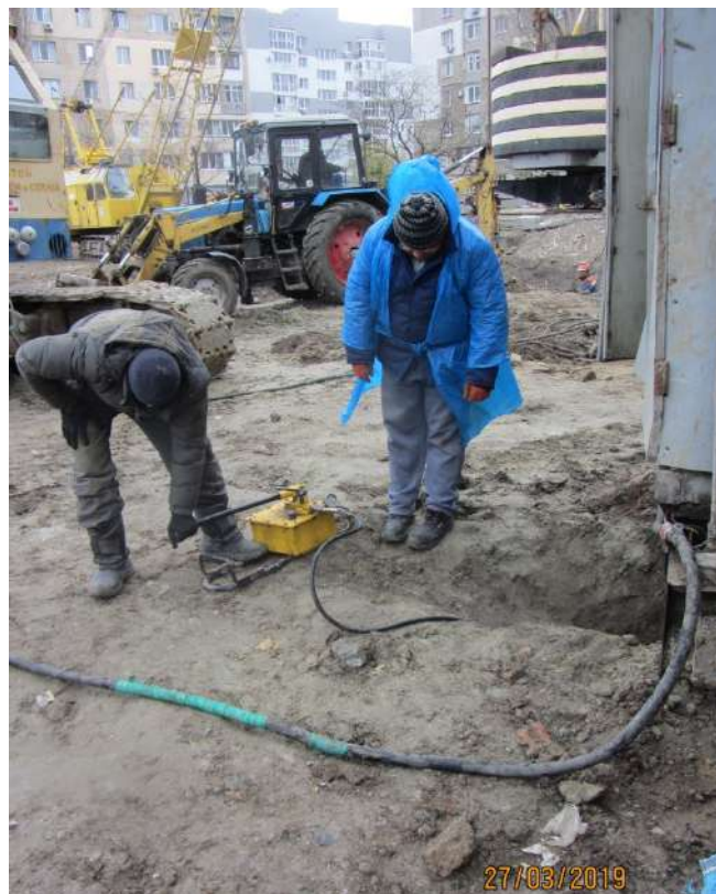
Рис. 5.18. Статичні випробування паль під цивільну будівлю з використанням пальовдавлюючої установки. Керівник робіт – с.н.с. Кушак С.Й.
