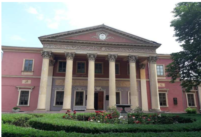
Рис. 1. Общий вид части главного фасада
