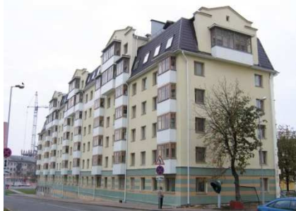
Реконструкція п'ятиповерхового будинку Мінськ, Білорусь з надбудовою мансардного поверху та без виселення
