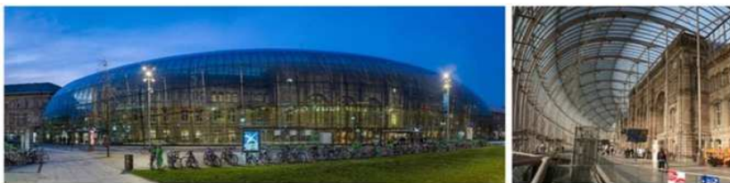
Рис. 3 – фасад железнодорожного вокзала Страсбурга
