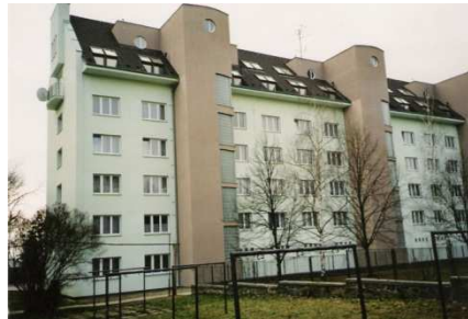
Реконструкція п'ятиповерхового будинку в Білорусії з надбудовою
