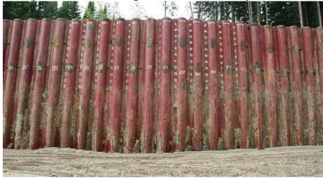
Рис.3.Укріплення за допомогою трубошпунта.
