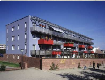
Приклади реконструкції п'ятиповерхових будинків в Німеччині, архітектор Ш. Форстер, проект "Східне відродження"
