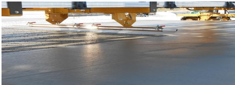
Рис. 5. Нанесення «шорсткості» та поверхні покладеного бетону ЗПС
