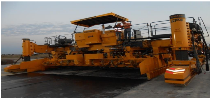
Рис. 1. Бетоноукладач Gomaco GP4 з ковзною опалубкою
