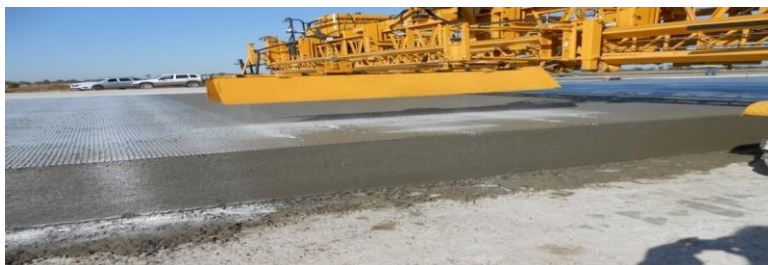
Рис. 6. Нанесення плівкоутворювального складу на свіжоукладений бетон
