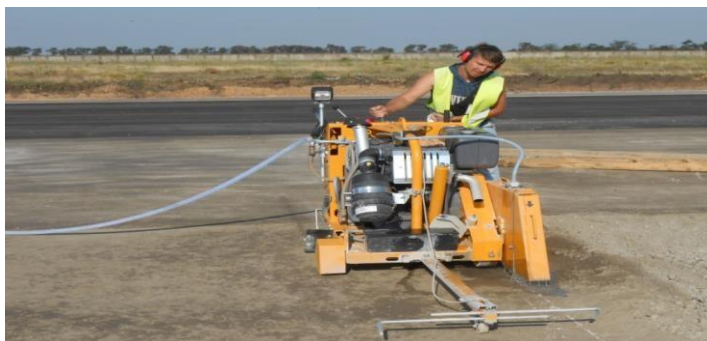
Рис. 7. Нарізка швів у бетоні ЗПС, що твердіє
