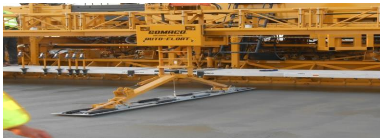
Рис. 4. Вигладжування поверхні свіжоукладеного бетону лижею
