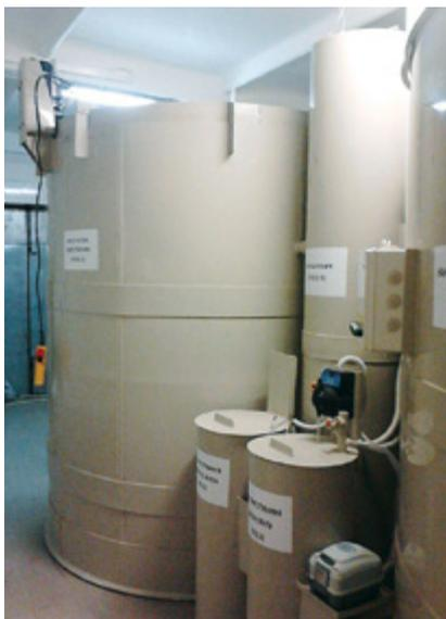
Станція очистки виробничих стічних вод загальною продуктивністю 1200 м<sup>3</sup>/добу для трикотажної фабрики в Хмельницькій області.
