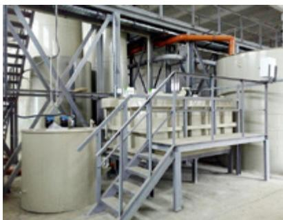
Станція флотаційного очищення виробничих стічних вод ковбасного цеху в Волинській області.
