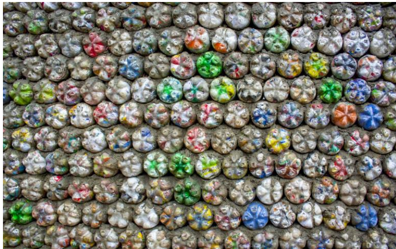
Рис.1. Стіна з EcoBricks
