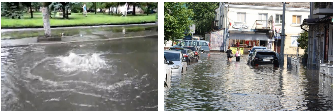
Рис. 1. Затоплення низинних ділянок міських територій через мережі дощового водовідведення: а) вилів води з колодезя; б) наслідки затоплення
