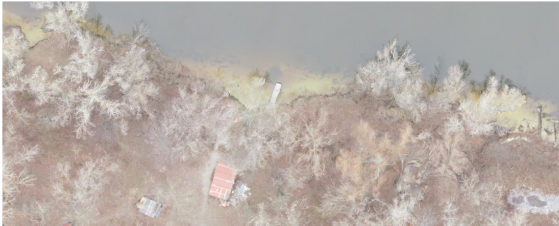
Рис.1 – Причал, будівля та відокремлений блок
