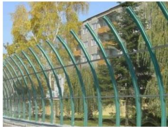
Рис.1. Шумозахисний екран з нахилом
