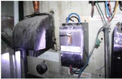
Рис. 2. Фото автоматичного вимикача з шунтовими перемичками входних та вихідних контактних груп по фазам "А" та "С".
