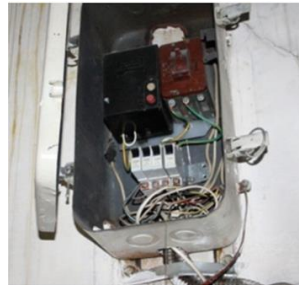
Рис. 3. Фото автоматичного вимикача з шунтовими перемичками входних та вихідних контактних груп по фазам "А" та "В".
