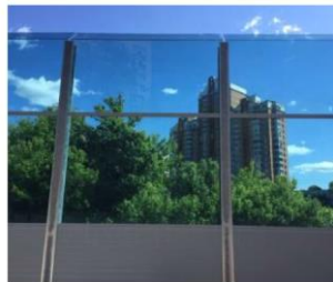
Рис. 2. Шумозахисний екран-стінка
