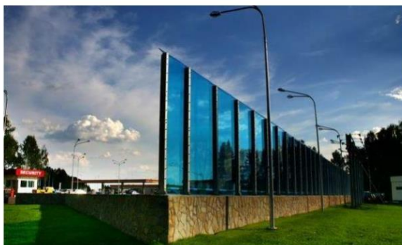
Рис. 4 – Світлопрозорий шумозахисний екран
