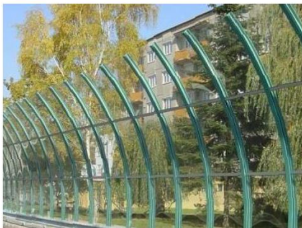
Рис. 2 – Шумозахисний екран з нахилом
