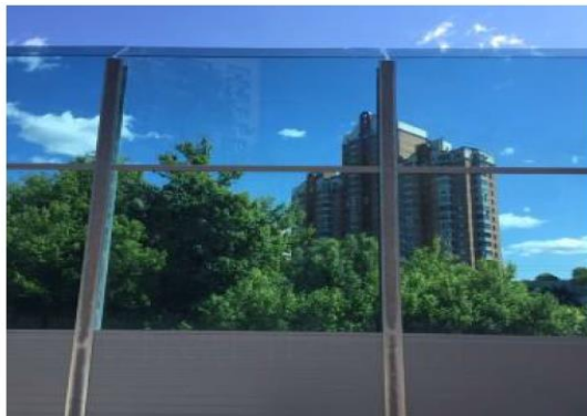
Рис. 3 – Шумозахисний екран-стінка
