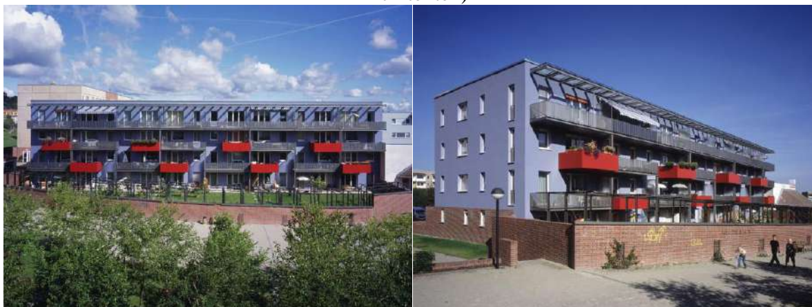
Рис. 3. Лайнефельд. Вид панельного будинку після реконструкції (Фото: Stefan Foster Architekten)
