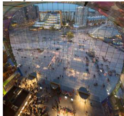
Рис. 4. Ринок Марктхал, Роттердам. Найбільший вантовий (різновид спайдерного) скляний фасад у Європі
