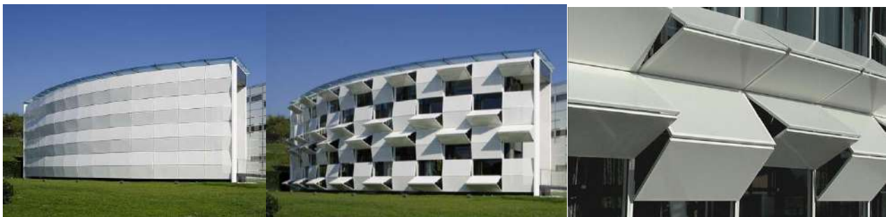
Рис. 2. Kiefer Technic Showroom, Бад-Глайхенберг (Австрія), 2007 р., арх. бюро Giselbrecht + Partner ZT GmbH
