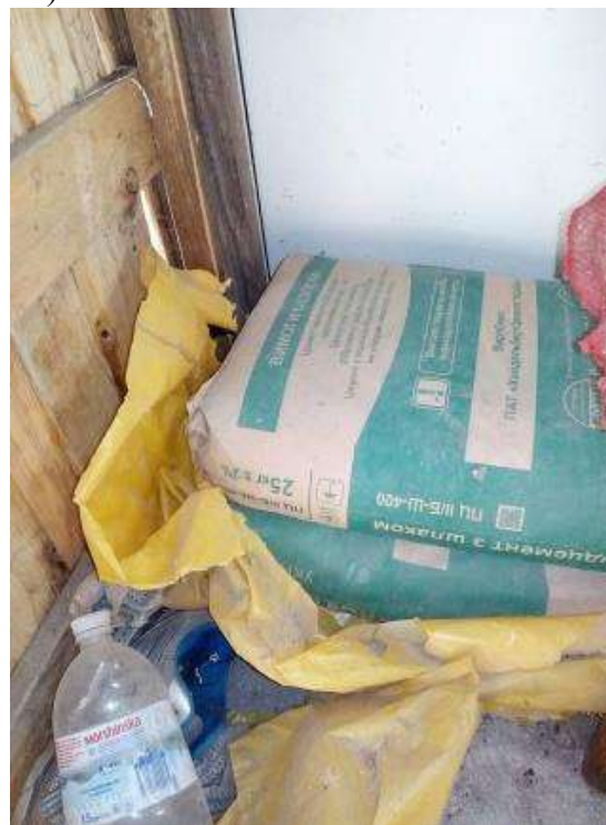
Рис. 2. Зберігання другої партії цементу в холодній прибудові
