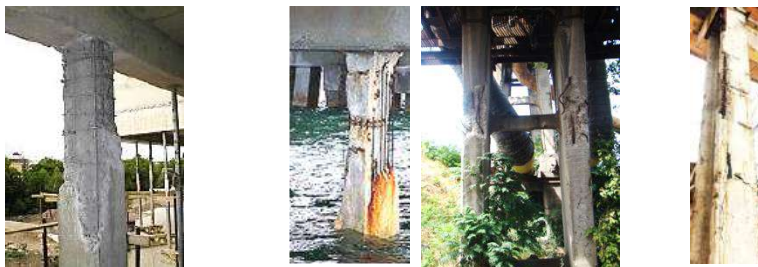
Рис. 1. Руйнування бетону в стиснутих елементах
