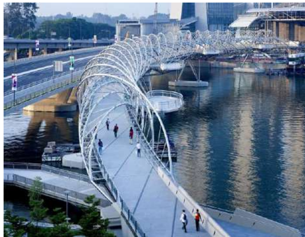
Рис. 6. Міст Хелікс. Загальний зовнішній вигляд
