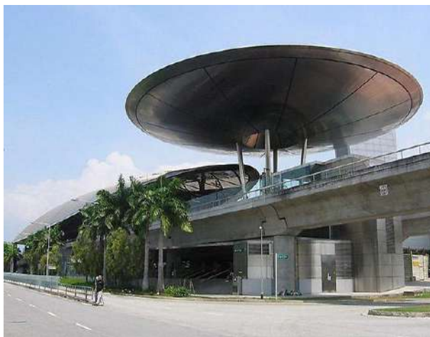
Рис. 5. Станція Ехро MRT. Загальний зовнішній вигляд
