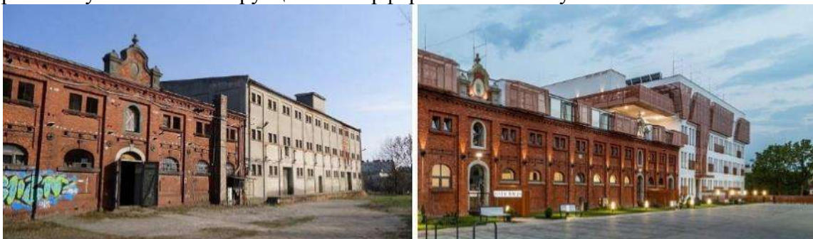
Рис. 3. Реконструкція колишньої ферми в сучасний центр для людей похилого віку
