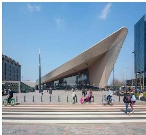
Рис. 4. Центральний залізничний вокзал Роттердама: фасад, привокзальна площа
