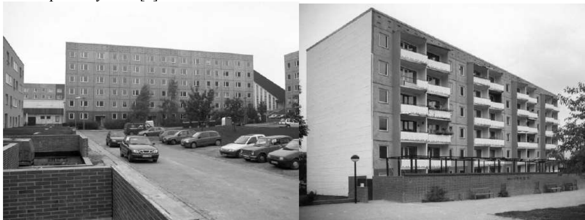
Рис. 2. Лайнефельд. Вид панельного будинку до реконструкції (Фото: Stefan Foster Architekten)
