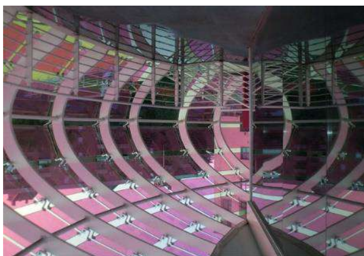
Рис. 2. Фрагмент остекления фасада
