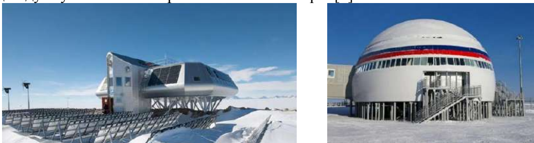
Рис. 1. Ліворуч: антарктична станція Princess Elisabeth, керована Бельгією. Праворуч: «Арктичний трилистник», приклад влаштування пального фундаменту та опор над землею
