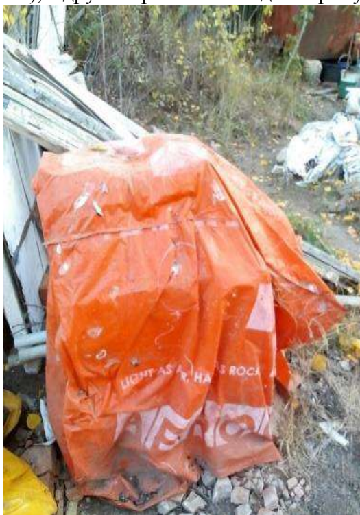
Рис.1. Зберігання першої партії цементу під відкритим небом
