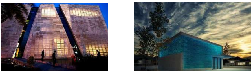
Рис. 4. Застосування літракону у сучасному фасадному дизайні
