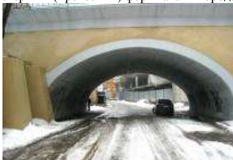
Рис. 2. Вид моста после реконструкции.
