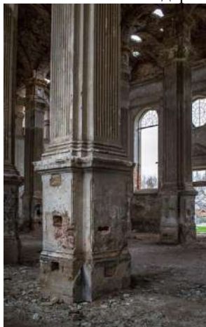
Рис. 3. Загальний стан несучих конструкцій: колон та цегляних сводів.
