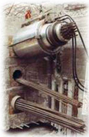
Рис. 4. Напружена арматура.
