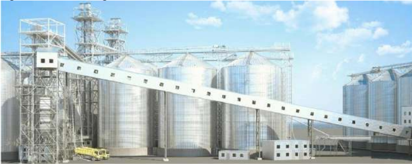
Рис. 1. Загальний вигляд конвеєрної галереї.
