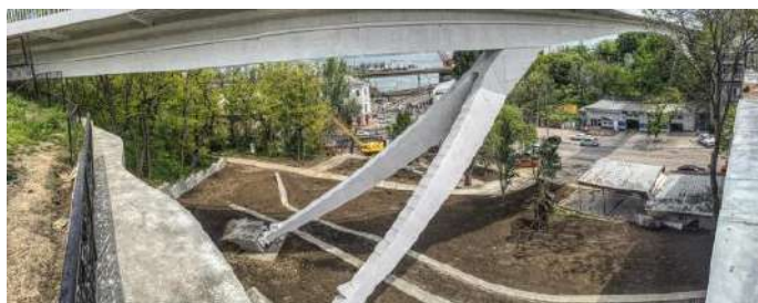
Рис. 3. Укрепление опор Тёщиного моста со стороны улицы Гоголя.
