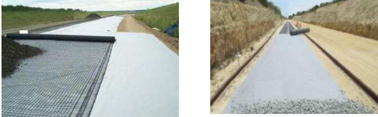
Рис. 2. Використання геосинтетичних решіток на об'єкті.
