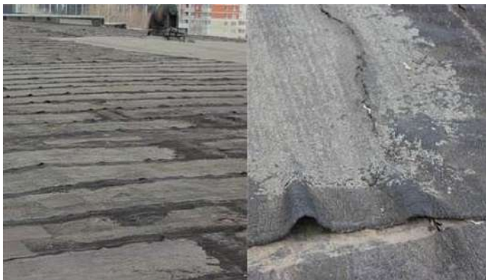
Рис. 4. Повреждения кровли.
