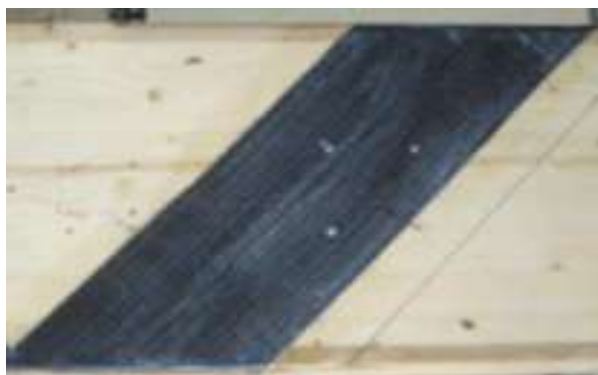
Рис. 4 - Підсилення похилих перерізів дерев'яної балки для збільшення сприйняття зсувних зусиль
