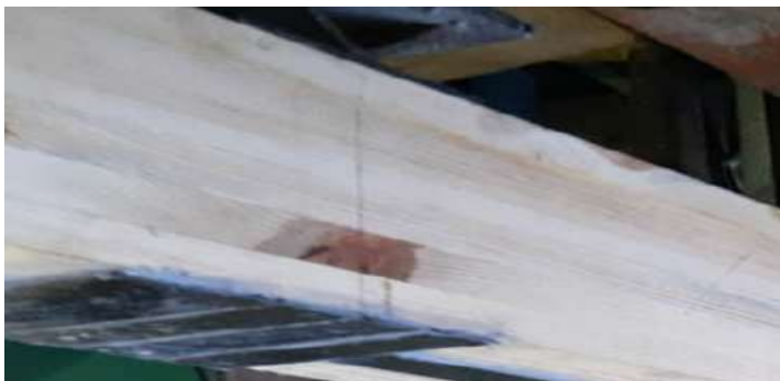
Рис. 3 - Кріплення країв композитної стрічки на дерев'яній балці
