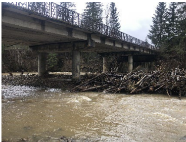
Багатопролітний балковий залізобетонний міст км 36+648
