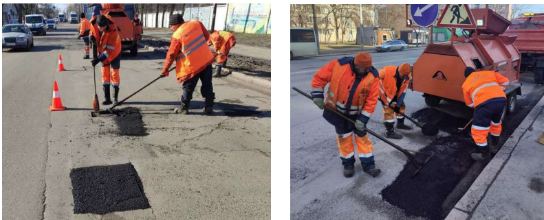
Рис. 2. Виконання робіт з ліквідації ямковості в осінньо-зимово-весняний період у Дарницькому р-ні м. Києва (2022-2023)
