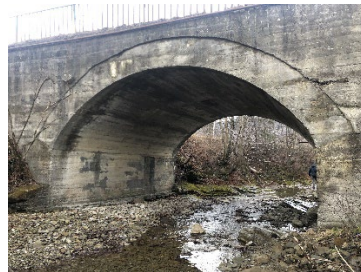
Арочний залізобетонний міст км 19+866
