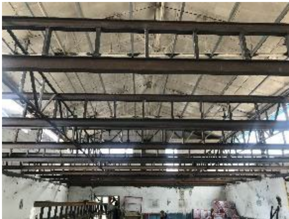
Рис. 2. Вигляд змонтованих металевих ферм комбінованого перекриття
