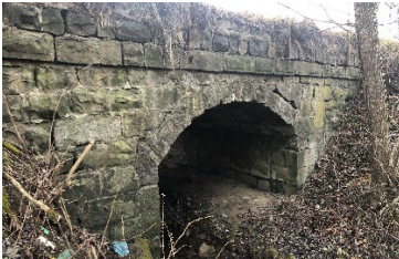
Арочний кам'яний міст км 18+264
