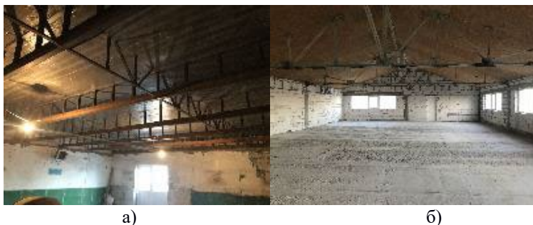
Рис. 3. Комбіноване перекриття: а) – вигляд знизу; б) – вигляд зверху.
