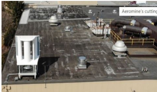
Рис. 1. Вітряк N_{ел} < 2 кВт та вентиляція N_{ел} > 20 кВт на даху будинку.
