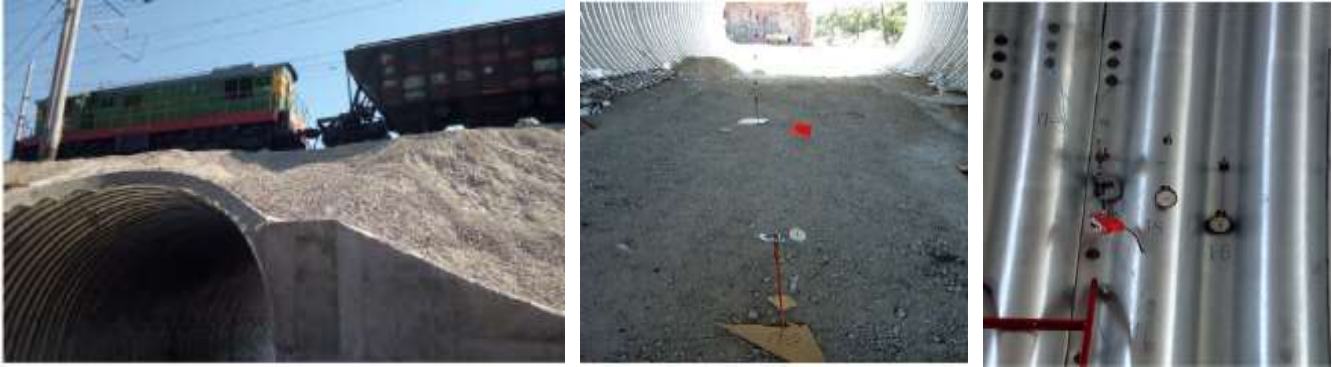
Рис. 11. Процес експериментальних випробувань шляхопроводу із МГК
