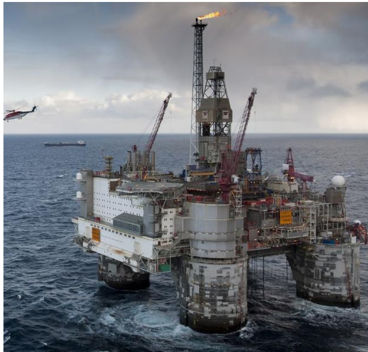
Рис.1.3. Плавуча нафтова платформа Heidun. Побудована з легкого бетону класу по міцності LC60 та марки за середньою густиною D1950
