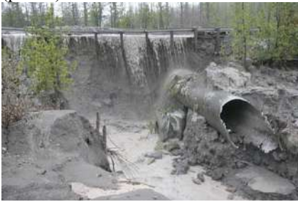
Рисунок 1 – Пошкодження дорожньої водопропускної споруди з МГК на шосе 35 внаслідок повені
