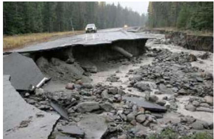
Рисунок 1 – Пошкодження дорожньої водопропускної споруди з МГК на шосе 35 внаслідок повені
