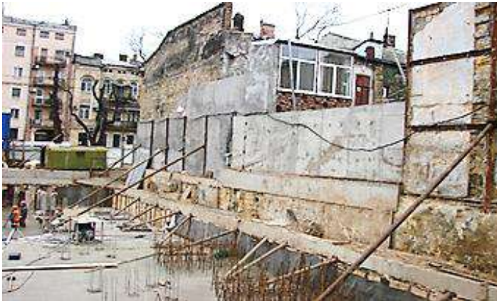
Рисунок 1 – Фото влаштування захисту стін котловану зі сторони прилеглих будівель і їх превентивного підсилення
