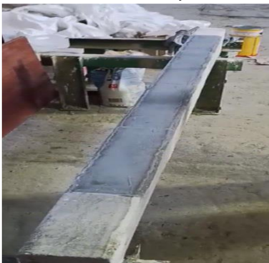
Рис. 5 Підсилення балки вуглепластиковим полотном Sika®Wrap®-230C на двокомпонентній смолі Sikadur-300
