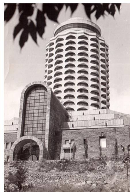
Общественное здание в г.Баку, в проектировании которого принимал участие М.Л. Бурышкин
