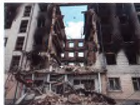
Зруйновані та пошкоджені будівлі
